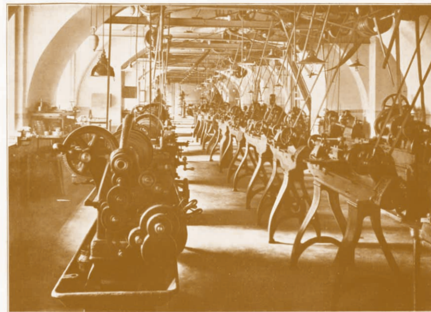
➤ Mechanické dílny pro praktická cvičení posluchačů Vysoké školy strojního a elektrotechnického inženýrství ČVUT (VŠSEL) na Karlově náměstí.
