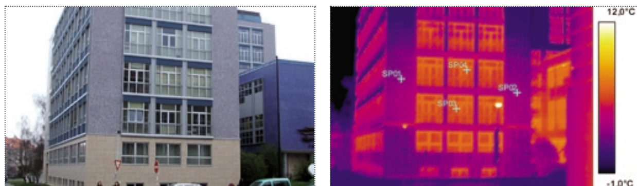
Monoblok – Fakulta elektrotechnická, část se vstupem ( před rekonstrukcí )
