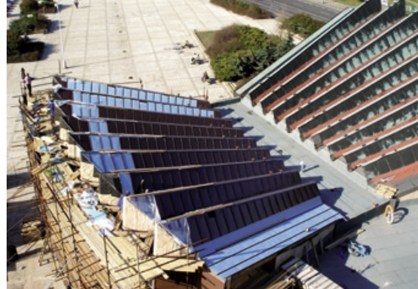
Pohled z ptáčí perspektivy na průběh a konečný výsledek zateplení a výměny střešní krytiny přednáškových sálů
