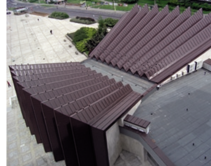
Pohled z ptáčí perspektivy na průběh a konečný výsledek zateplení a výměny střešní krytiny přednáškových sálů
