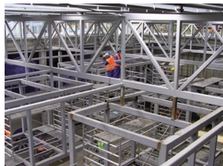
1. 4. 2008: konstrukce kostek hotovy
