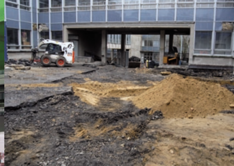
7. 12. 2007: bourání dvorní části
