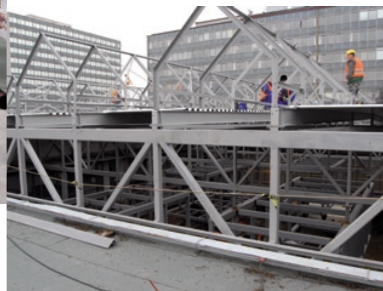
4. 3. 2008: montáž ocelové konstrukce
