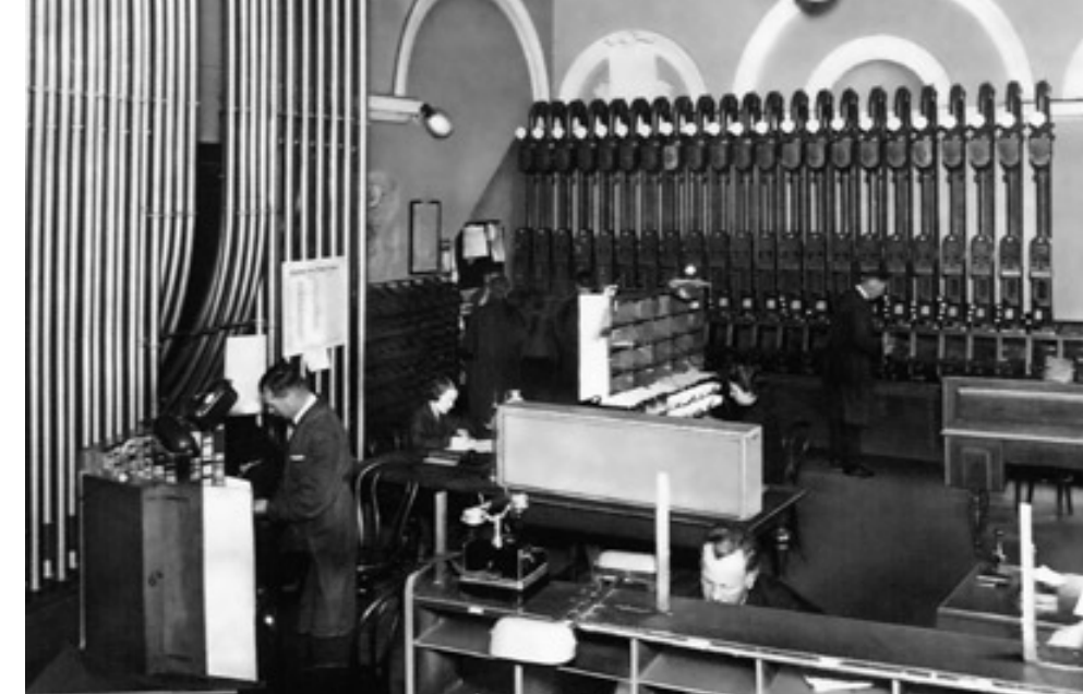
Ústředna potrubní pošty na hlavní poště v Praze v Jindřišské ulici
