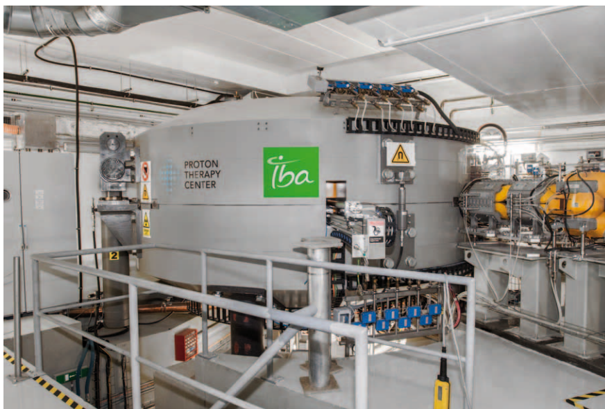
Cyklotron používaný k urychlení protonů ➔
