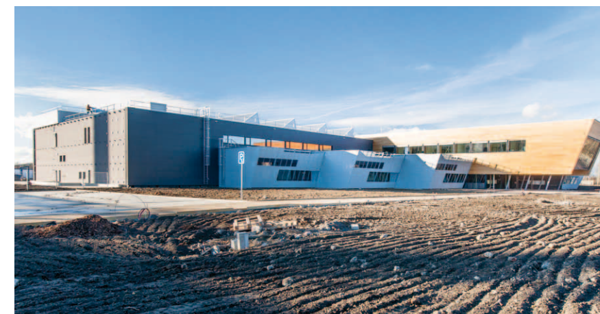
Postdoktorandi Fakulty stavební mají zázemí v Univerzitním centru energeticky efektivních budov v Buštěhradu
